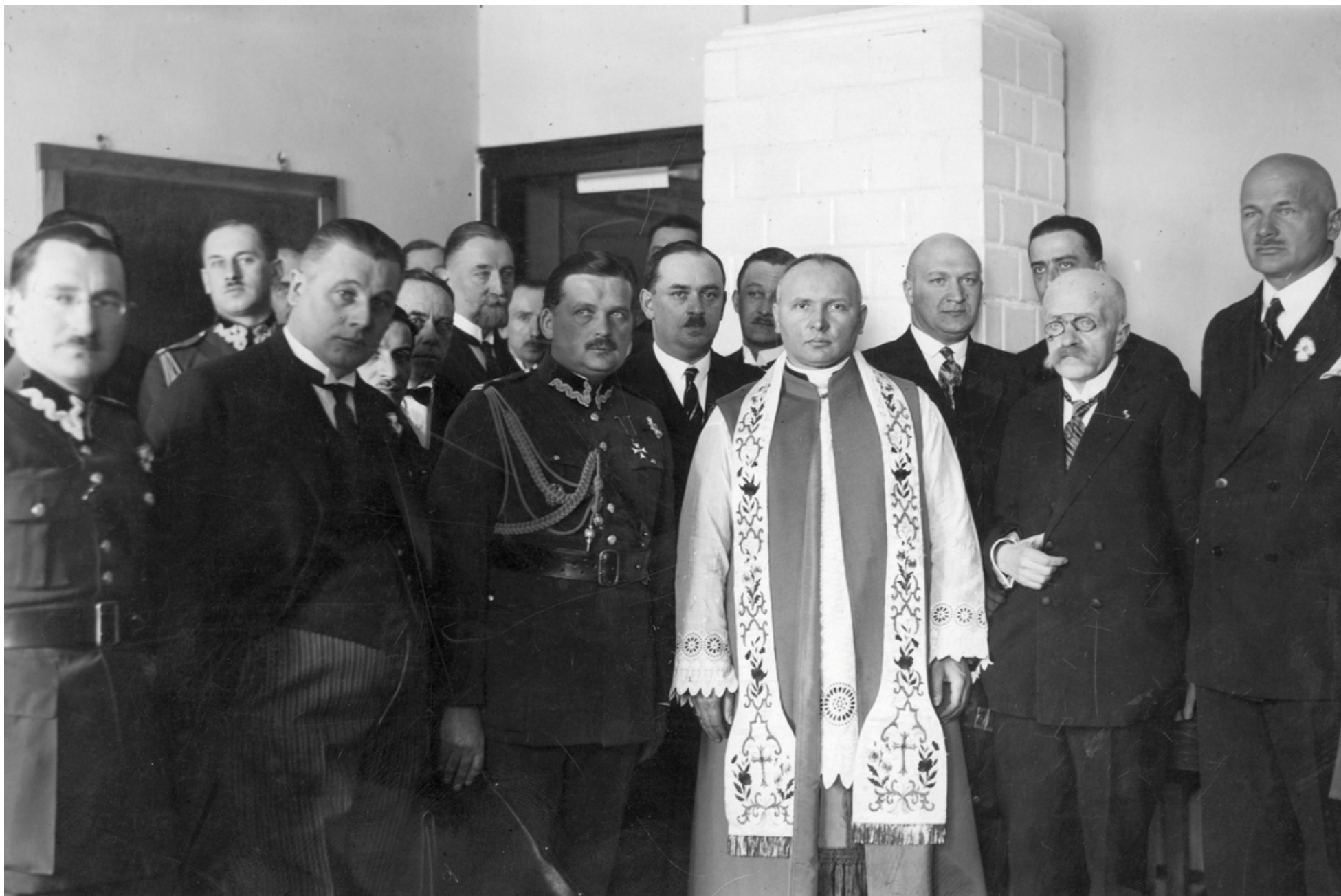
Rys. 3. Poświęcenie tymczas. lokalu Inst. Radiotechnicznego (ITR) w W-wie, 1929.3.16
