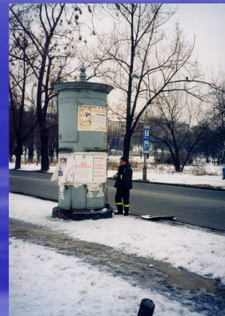
Stacja elektroenergetyczna 5 kV typu kiosk
