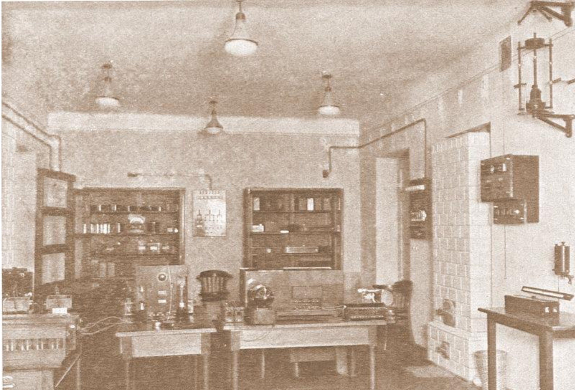
(P.I.T.). Widok pomieszczenia - laboratorium pomiarów teletechnicznych
