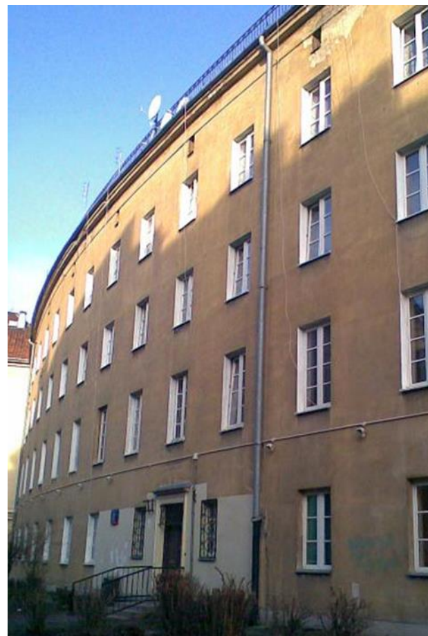
Rys. 4.11. Przykład braku koordynacji przewodu odprowadzającego z innymi instalacjami na budynku Akademika przy placu Narutowicza
