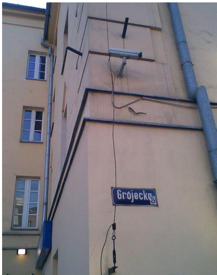
Rys. 4.11. Przykład braku koordynacji przewodu odprowadzającego z innymi instalacjami na budynku Akademika przy placu Narutowicza
