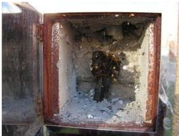
Rys. 4.13. Przykłady zdewastowanych zacisków probierczych
