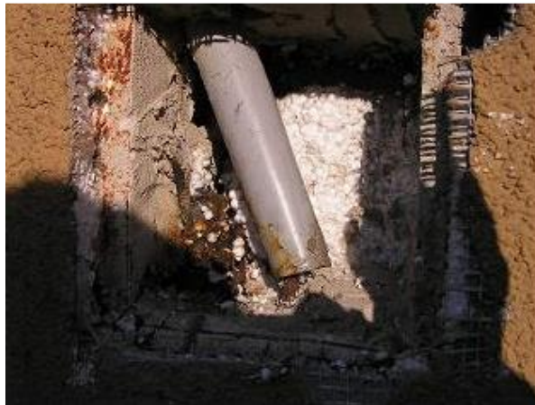
Rys. 4.13. Przykłady zdewastowanych zacisków probierczych
