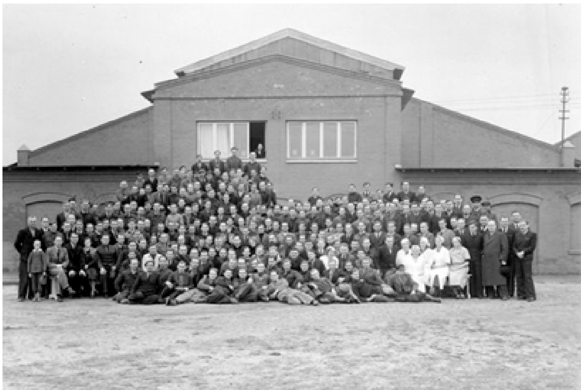
Pracownicy przed frontonem budynku FAE
