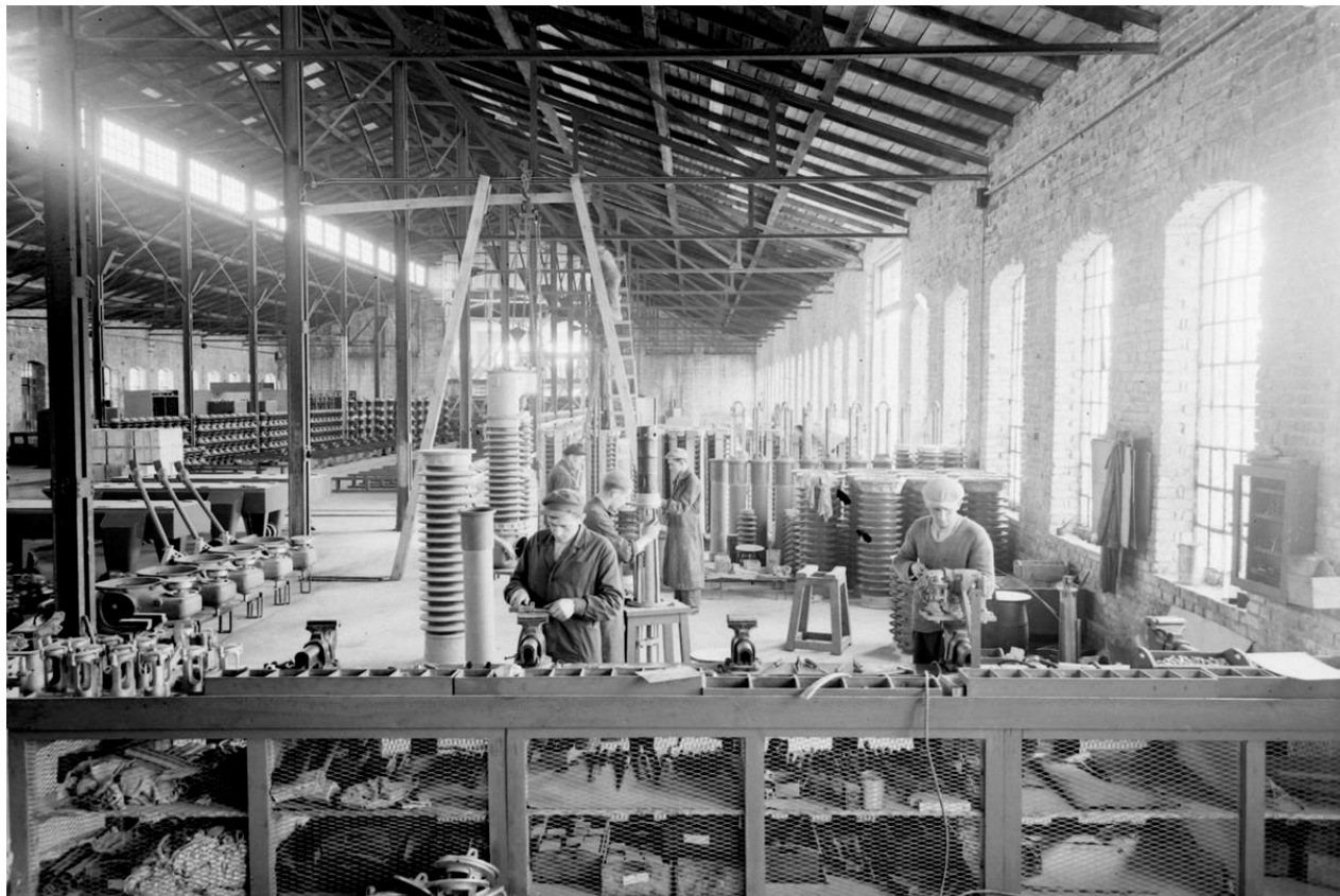
Hala fabryczna FAE, montaż aparatury na 150 kV, Międzyzlesie
